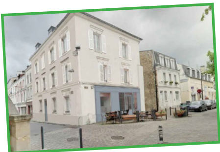
Brunoy Rénovation de 8 logements Livraison : juin 2020
