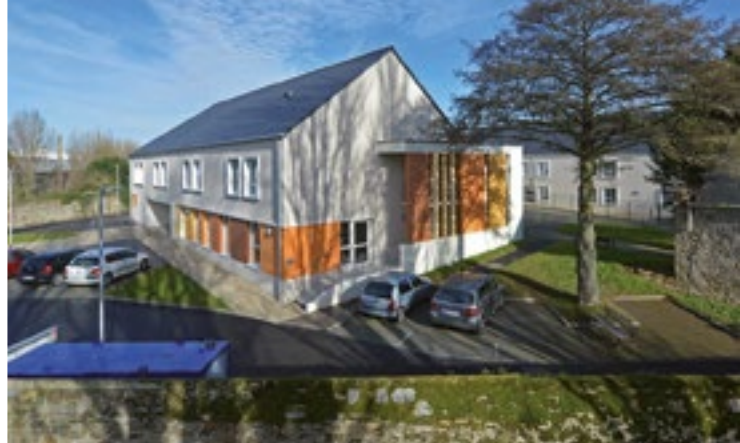
EHPAD Plessis-Pont-Pinel à Saint-Malo (35)
